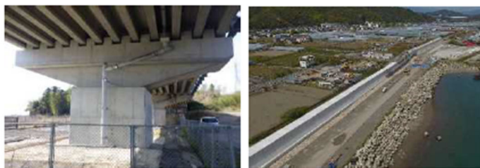
緊急輸送道路上の橋梁の耐震化
