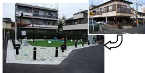
避難場所（公園・広場）の整備による密集市街地の安全性向上
