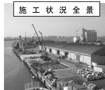
写－1 施工状況写真
